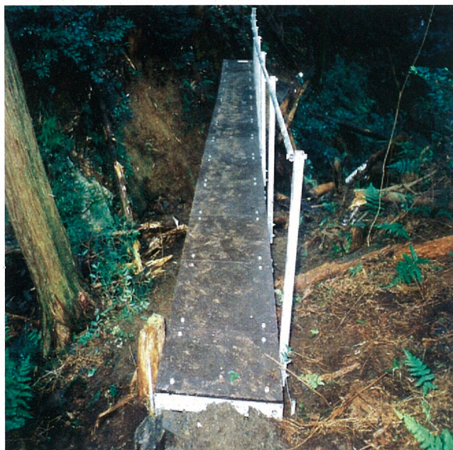
手摺りあり巡視路用組立橋
