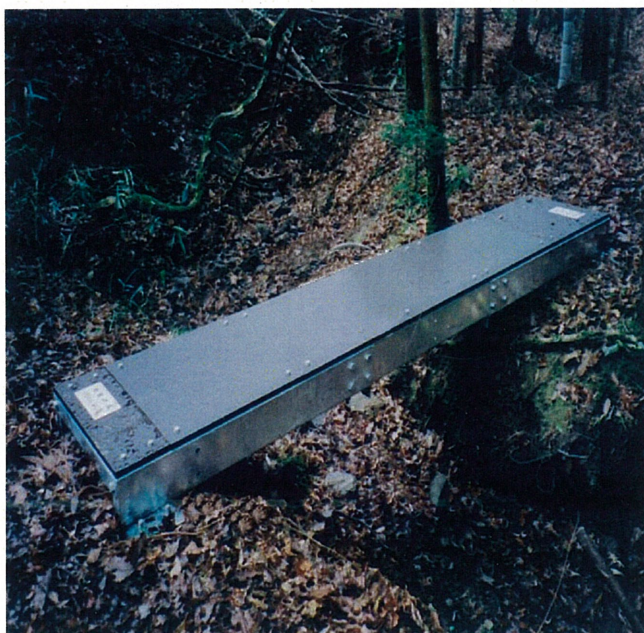
手摺りなし巡視路用組立橋
